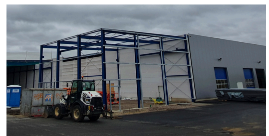
Construcción de nuevo centro de línea de tubos
